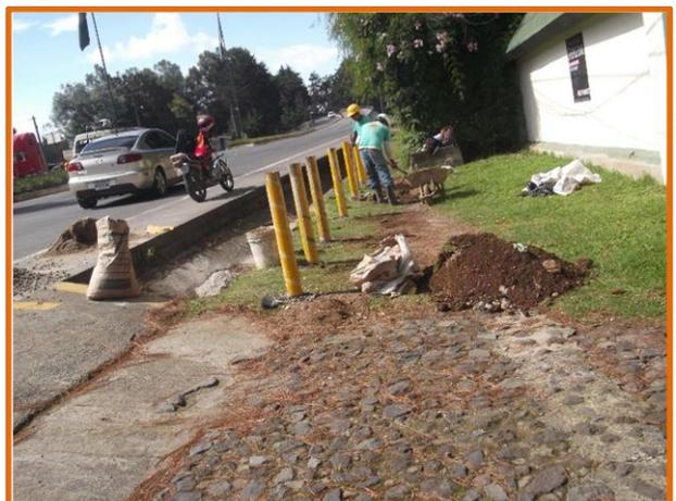
CONFORMACION DE TALUD Y ELABORACION DE CAJA DE UNION DE DRENAJE EN CHILAYON
