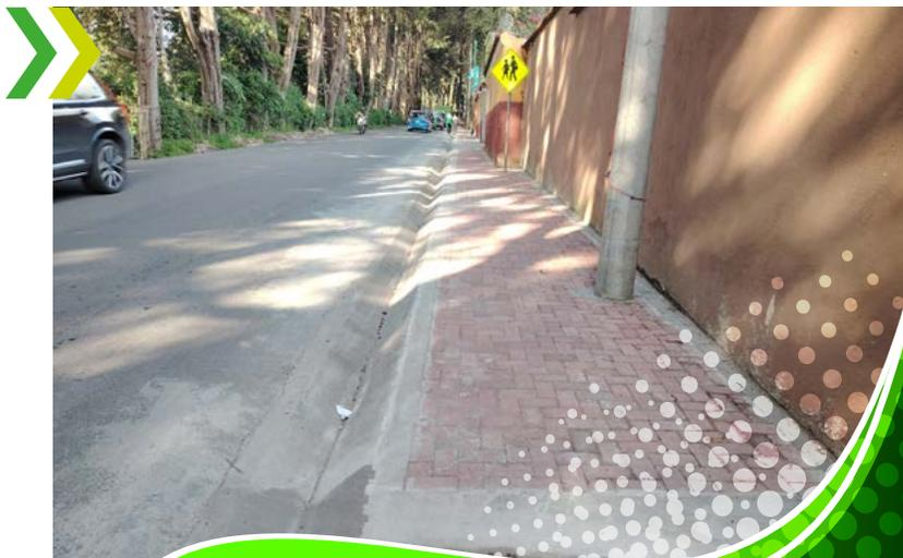
Longitud de 410 metros, ancho 1.20 metros para un total de 492 metros cuadrados, 820 metros lineales de bordillo fundido, 6 metros de llaves de confinamiento y adoquín tipo cruz clase A.
