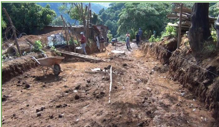
En la calle Real de la aldea La Embaulada se trabaja en la actualidad en el proyecto de adoquinamiento del tercer callejón de la aldea mencionada, el área de adoquinamiento es de 312 metros cuadrados, son 132 metros lineales de bordillo fundido, 52 metros lineales de llaves de confinamiento, un pozo de absorción con su respectiva rejilla metálica para permitir la captación de aguas pluviales.
