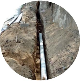
Trabajos de drenaje sanitario, construcción de acometida para drenaje sanitario, empotrado de previsto de drenaje en pozo existente en el kilómetro 30.5 zona 5.
