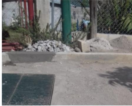
Mantenimiento y reparación de hundimiento en calle Los Cipreses, Caserío San José y en 6ta avenida sur zona 2 de San Lucas Sacatepéquez. Los trabajos consisten en la extracción de adoquín, nivelación de terreno y colocación de material selecto como base para la posterior colocación de adoquín.
