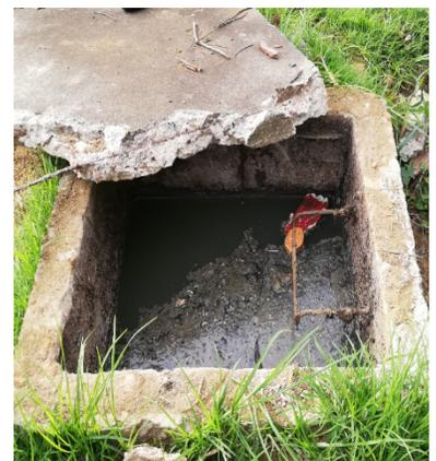
Limpieza de pozos de absorción y fosa séptica en Lotificación Prados de San Lucas, zona 2, los trabajos consisten en la extracción de desechos sólidos y líquidos de los pozos de visita y de la fosa séptica los cuales se encontraban colapsados.
