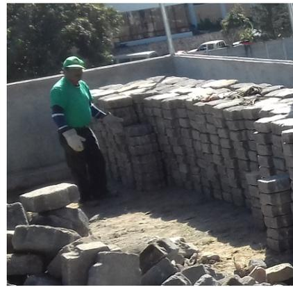
Reparación de bache en Callejón Los Jorges I, Cantón Reforma zona 2, los trabajos consistieron en levantamiento de adoquines alrededor del bache para realizar un relleno completo del agujero con material selecto, posteriormente la colocación de adoquín y relleno de sisa con arena de río.
