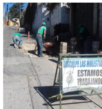
Construcción de carrileras en calle Los Frutales, Aldea El Manzanillo zona 6. Los trabajos consisten en colocación y compactación de material selecto, colocación de adoquín y relleno de sisa con arena de río, y fundición de bordillos de confinamiento.
