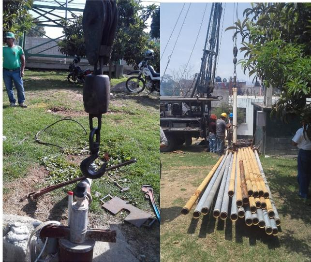
En el mes de julio se realizó la reparación de la bomba sumergible del pozo Bartolo, se instaló nuevo equipo consistente en :
