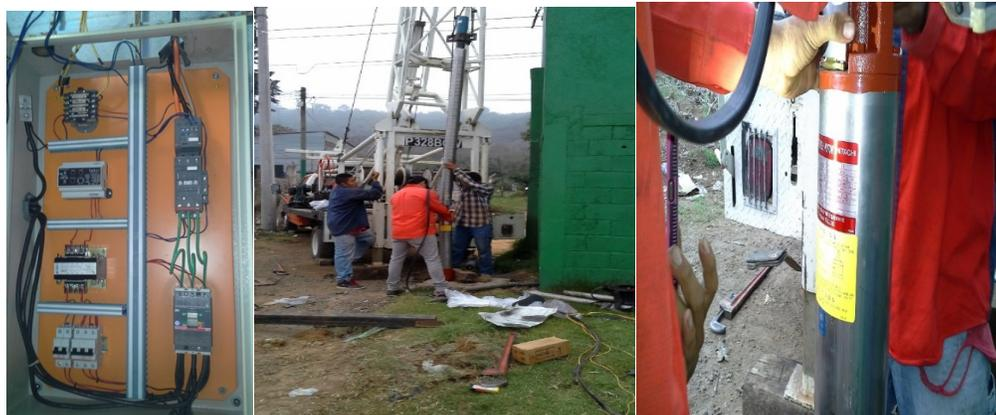
En el mes de abril se tuvo que hacer la instalación de equipo tipo turbina de 30 HP en el tanque cisterna se instaló bomba y motor reparados se cambiaron ejes y dos coplas de 1”.
