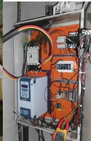
En el mes de octubre se reparó el tablero eléctrico del pozo de Florentina, ya que se dio un corto circuito se instaló:
